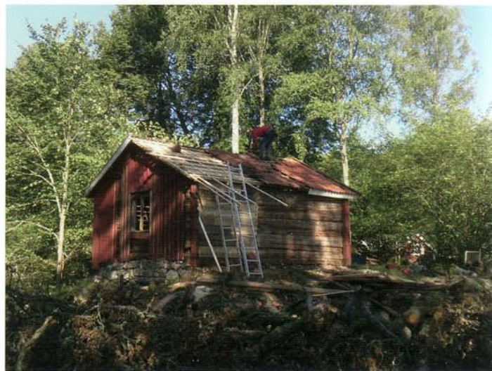
Renovering av uthuset på Bergön. Foto: Länsstyrelsen i Kronoberg
